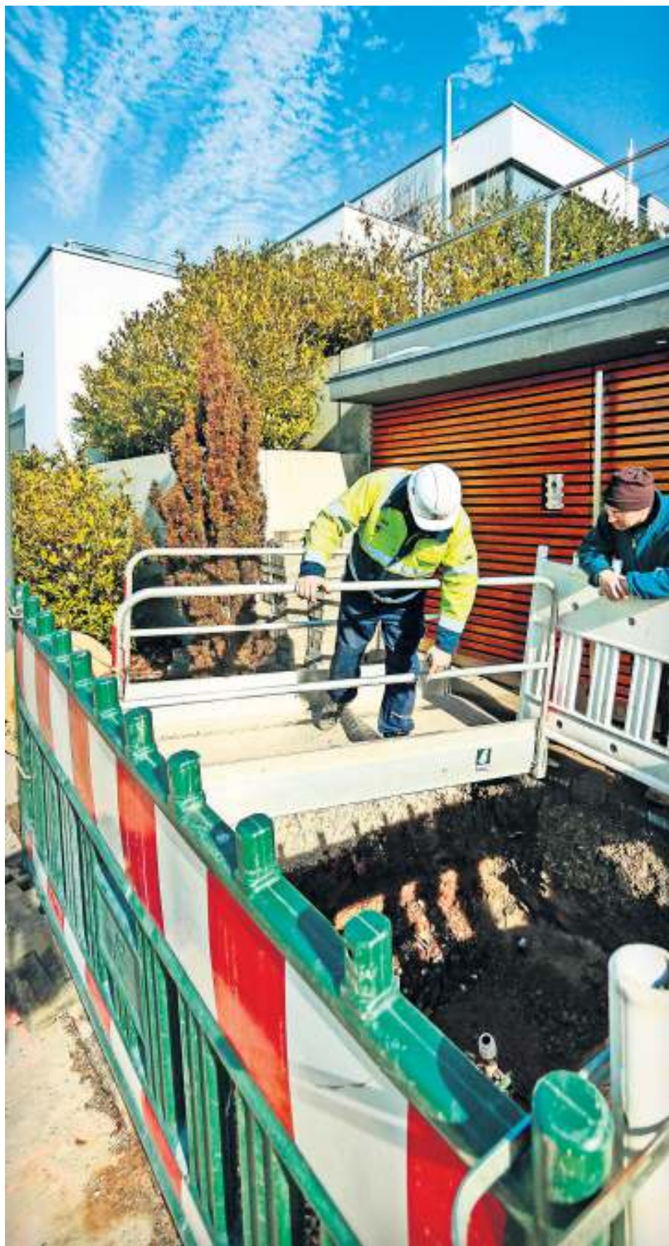
Im Heinrich-Heine-Weg beginnen in der kommenden Woche die Sanierungsarbeiten von weiteren acht schadhafte Bohrlöchern im Süden Böblingens. Foto: factum/Granville
