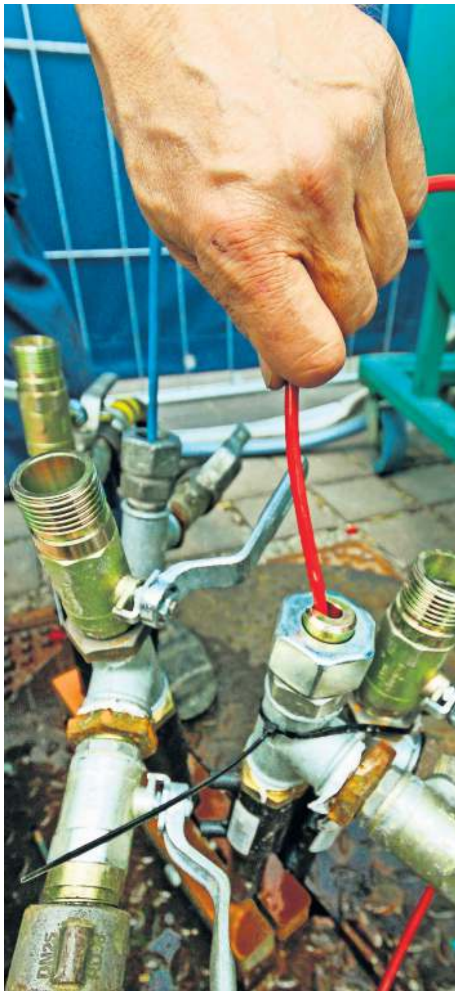
In die schadhafte Bohrlöcher wird eine Zementlösung gespritzt, um sie zu schließen. Insgesamt 17 Geothermiebohrungen werden so saniert. Foto: factum/Granville
